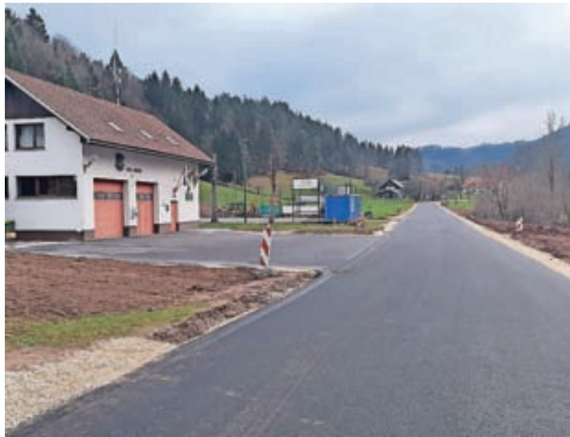
Obnovljena cesta v Račevi
